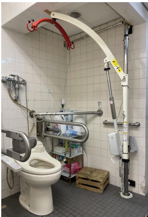
モニター用としてトイレに据え付けた固定式リフト（上の写真2枚）
